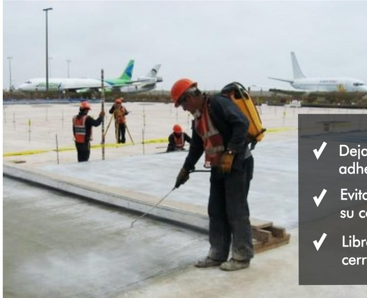
El sistema de Membranas de Curado consta de un agente curador de concreto que penetra las superficies curándolo desde adentro sin dejar residuos del agente de curado.
