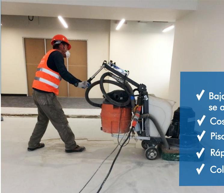
El sistema de desvastado y pulido en seco FGS PERMASHINE es un tratamiento que trabaja directamente con los componentes del concreto lo cual permite dar gran brillo y color a las superficies. A través de una sola aplicación logramos que la imagen de las superficies sean duraderas, agradables, elegantes, bonitas y con un aspecto limpio.
